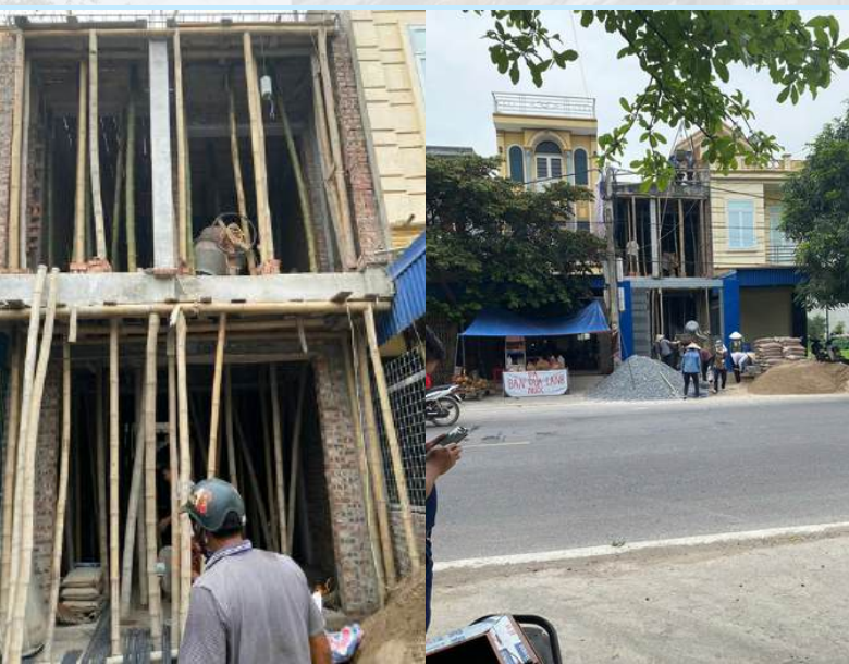
Hình ảnh thi công thực tế
